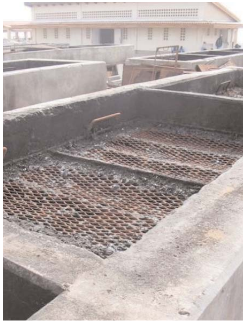
Grillage situé à 60 cm au-dessus du feu
